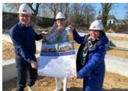
11 maart Startsein bouw Oude Haven in Odijk
